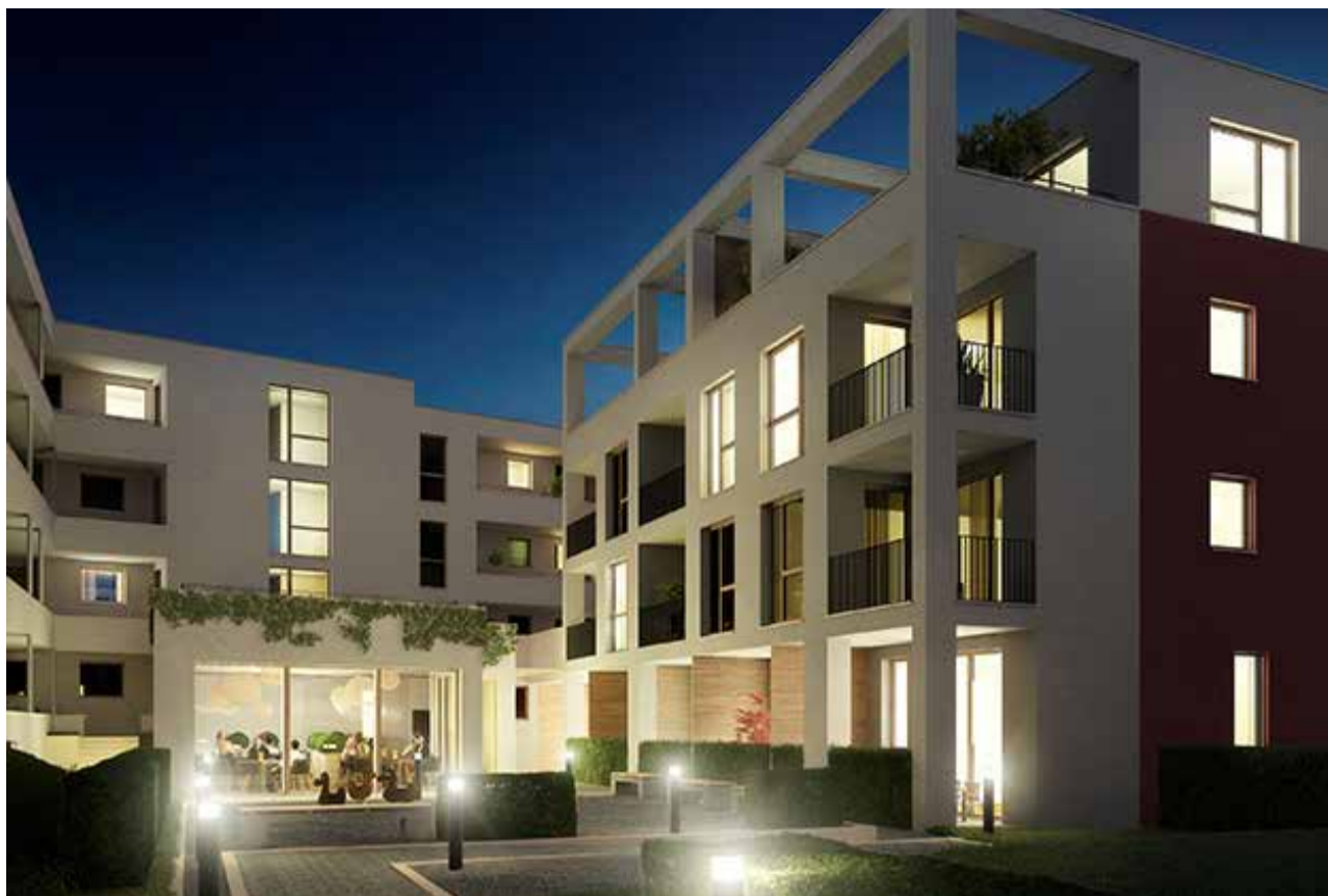
Die neue „meVita Residency am Riedbrunnen“ – hier können Senioren selbstbestimmt und unabhängig wohnen und leben.
