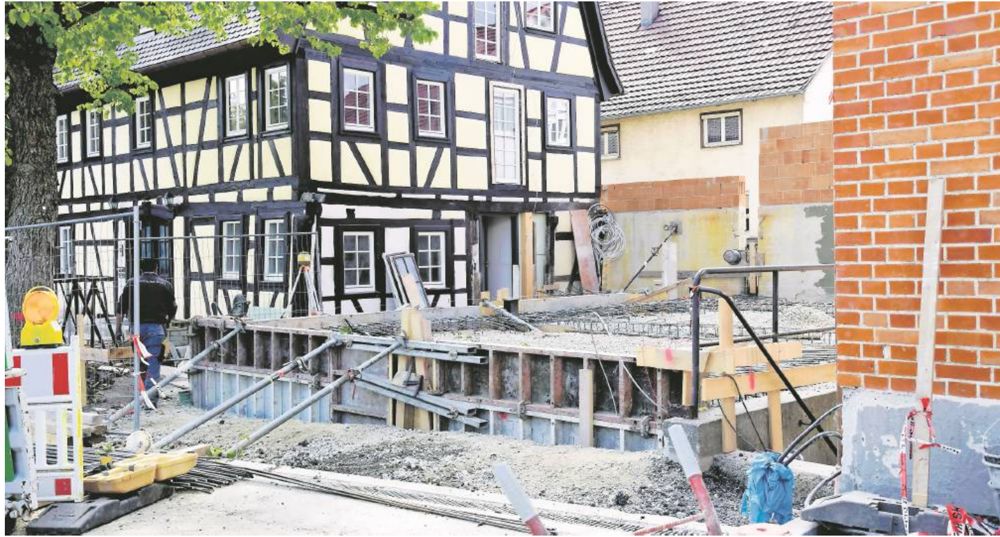
Zwischen den beiden bestehenden Gebäuden wird ein gläserner Verbindungsbau errichtet
